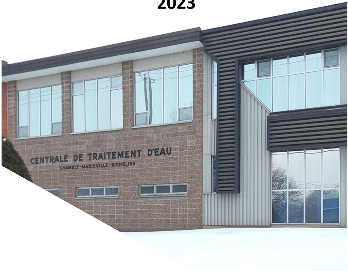
Centrale de traitement d'eau Chambly-Marieville-Richelieu, Chemin Ste-Thérèse, Carignan
